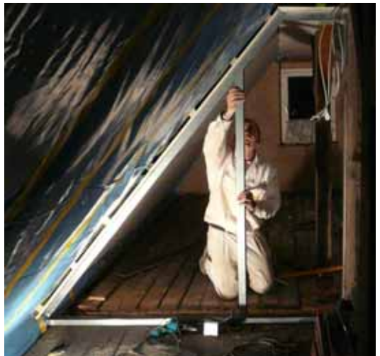
Walter Kron aus Ohmbach beim Einziehen einer Zwischenwand. Wenn Handwerker mithelfen, die ihre Arbeiten selbständig ausführen können, ist das natürlich besonders entlastend.
